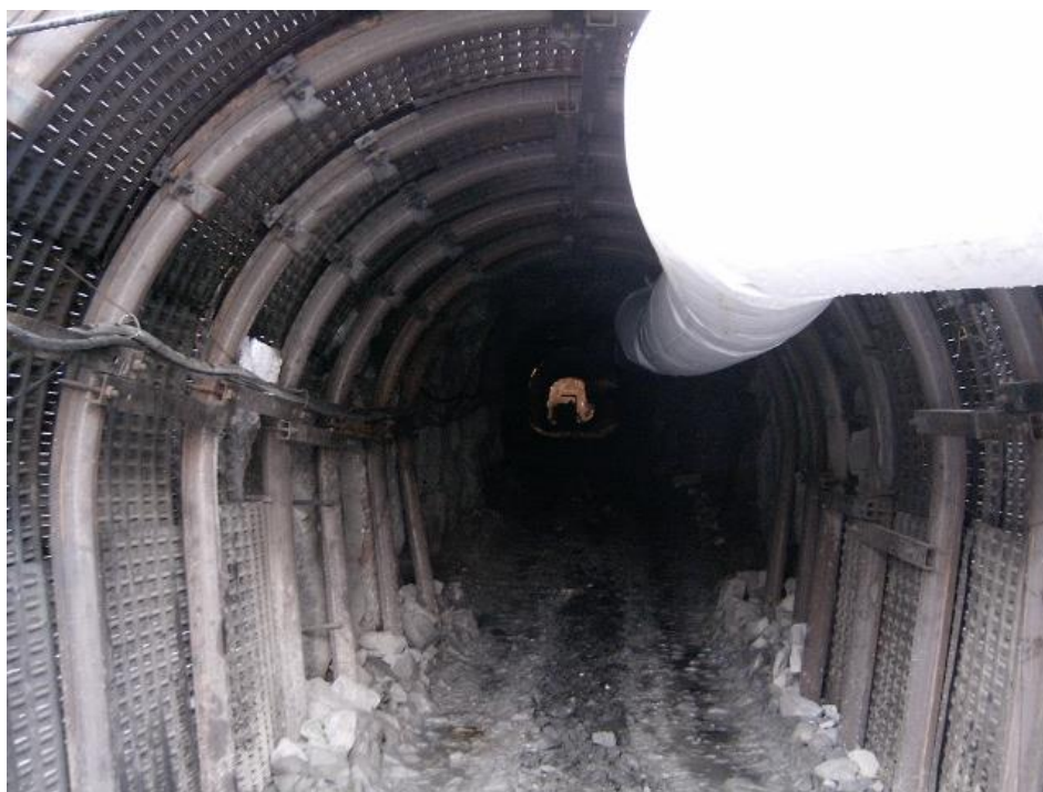
Detalle de la colocación de la chapa Bernold entre cerchas y vista del perfil de arriostramiento entre cerchas
