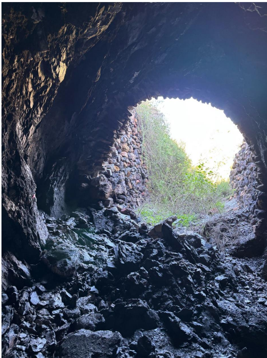
Vista de los primeros metros del túnel a la entrada desde Hipogeos
