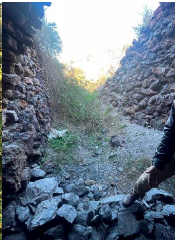
Fotografía tomada del informe de la dirección facultativa de las obras. Febrero 2023
