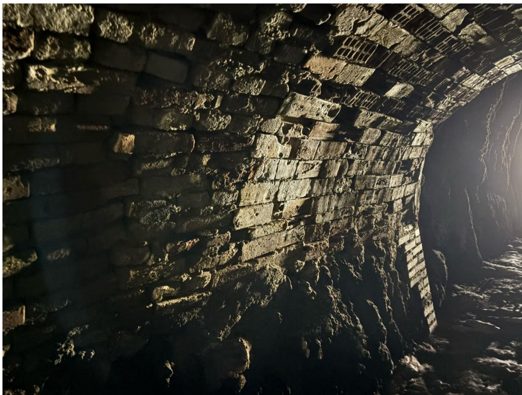
Aspecto del ladrillo existente a retirar para colocación del sostenimiento propuesto.
