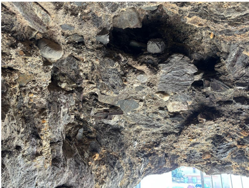
Detalle del material existente en la zona a sostener.
