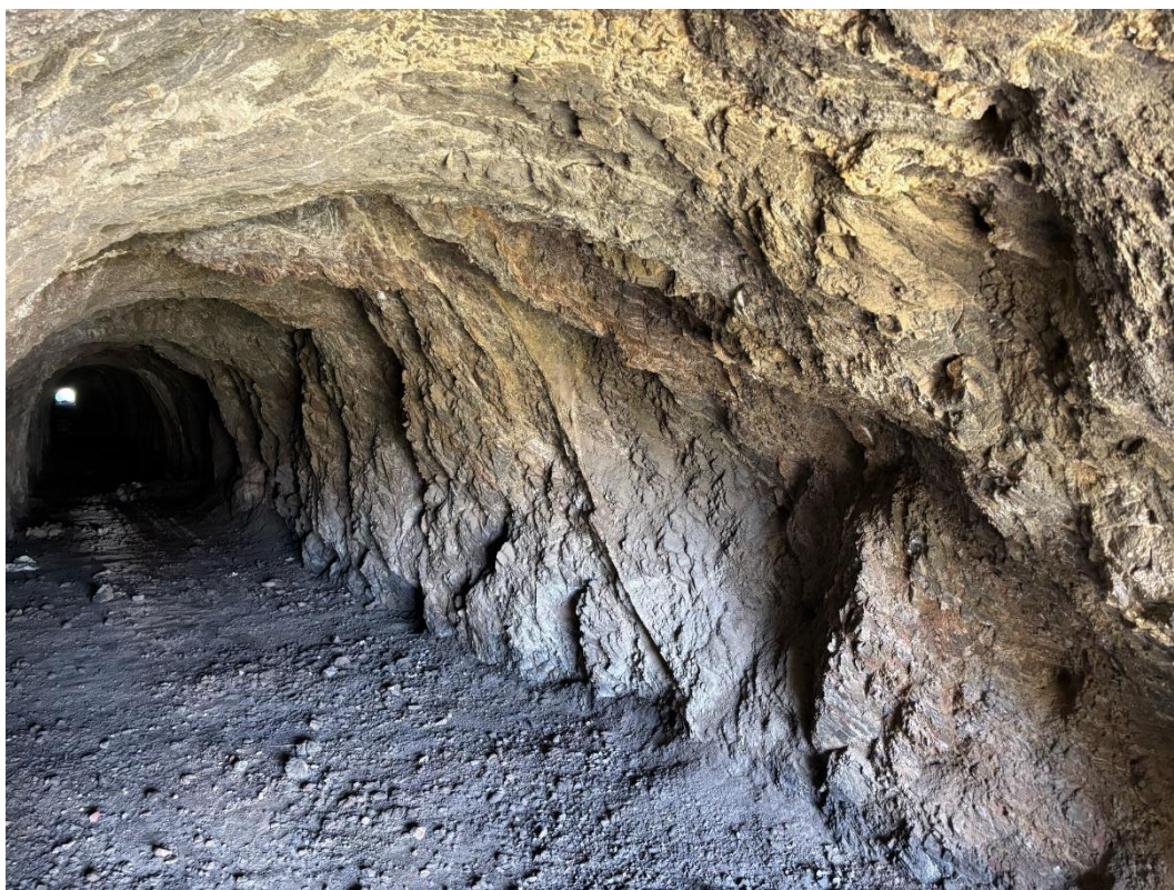
Vista desde el emboquille de Siret de la zona a intervenir.
