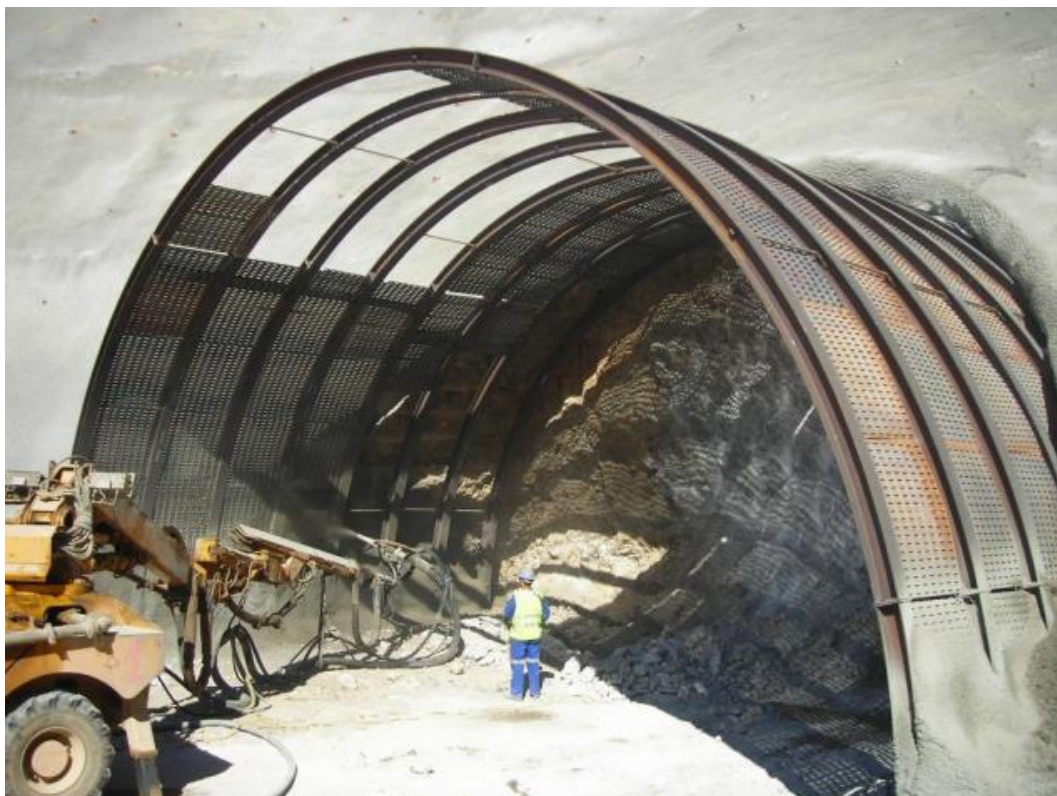
Detalle de un emboquille con cercha y chapa Bernold
